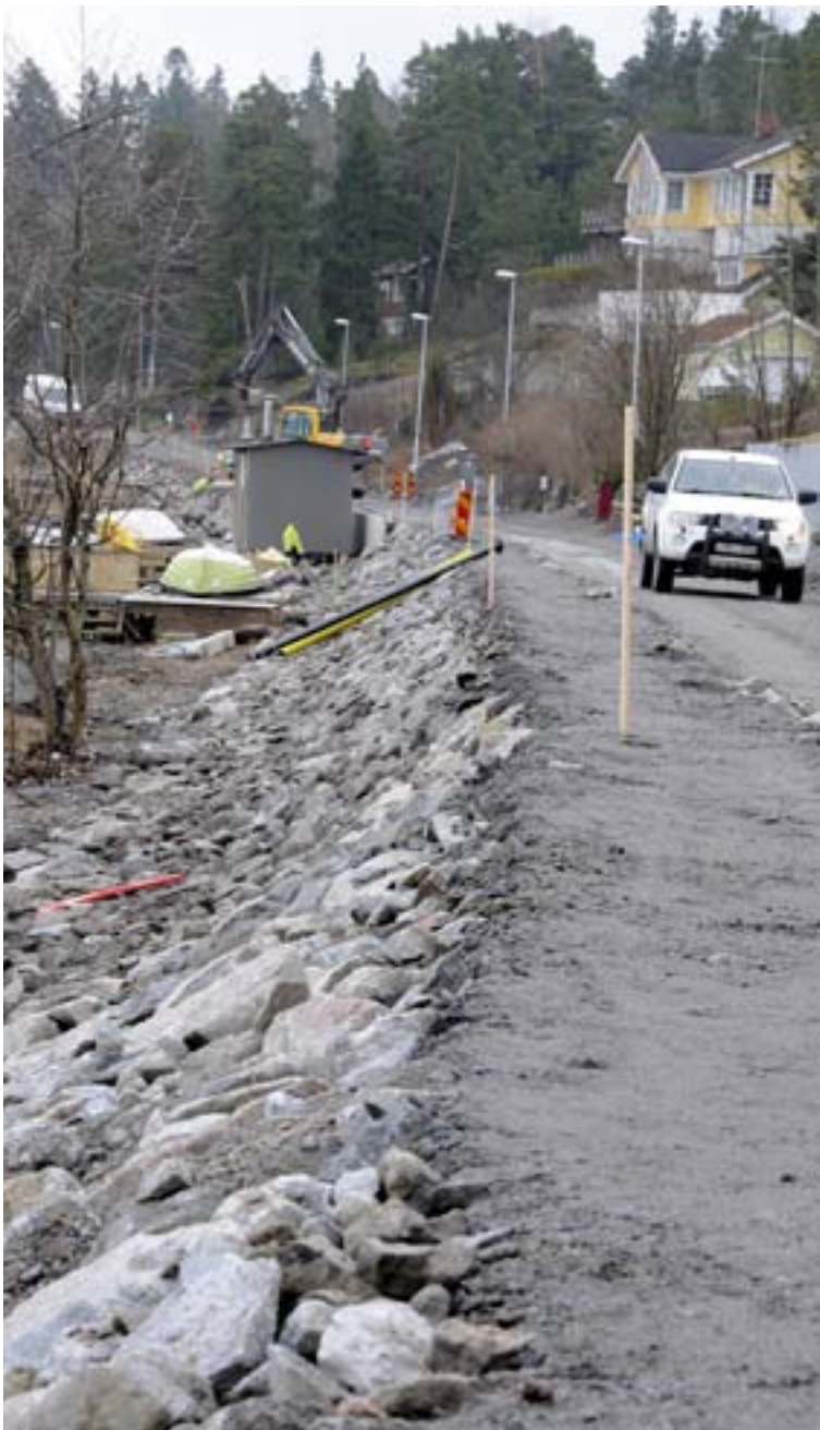
Rundade stenar skyddar mot Erstavikens vågor.
