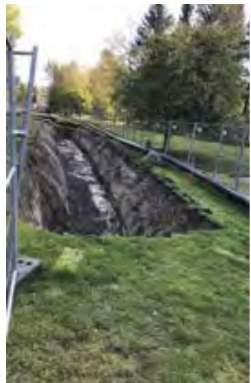
I rörgraven läggs det ner nya ledningar.
