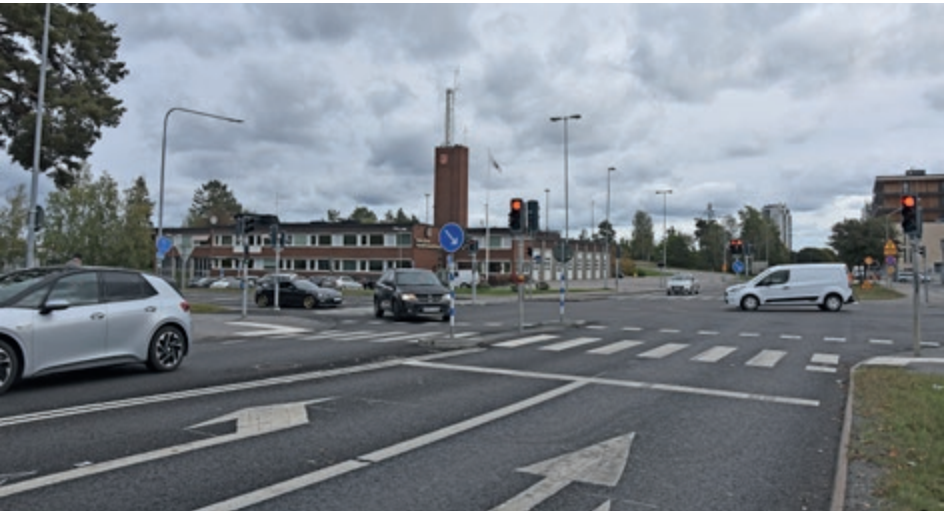
Bollmoravägens ombyggnad startar vid brandstationen.
