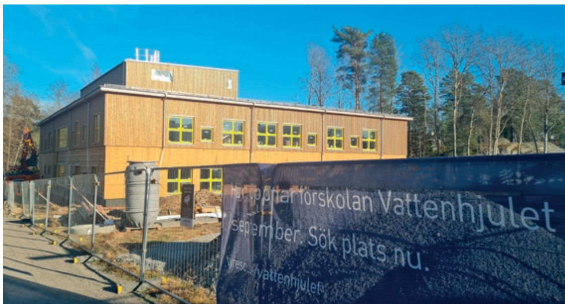
Förskolan Vattenhjulet i Fårdala under uppförande.
