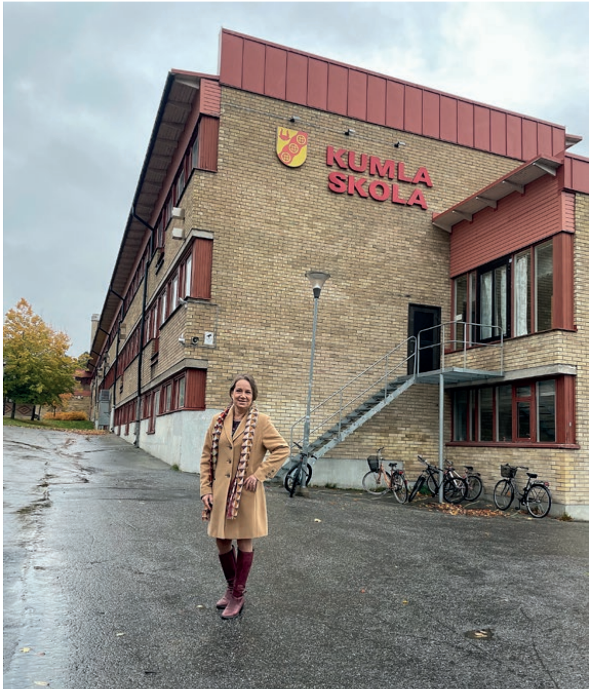
Anita Mattsson (S) KSO, utanför Kumla skola som nu ska genomgå en stor renovering. Även fler skolor i Tyresö rustas och renoveras. FOTO: TYRESÖ NYHETER
