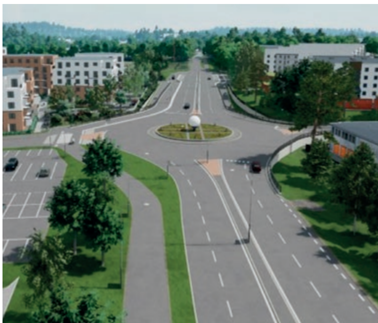
Exempelbild från Tyresö kommun över Bäverbäcken och Tyresövägen. Vid sidan om åtgärderna vid Tyresövägen pågår samtidigt en omvandling av industriområdet vid Bäverbäcken från verksamhetsområde till nytt område för bostäder. FOTO: TYRESÖ KOMMUN
